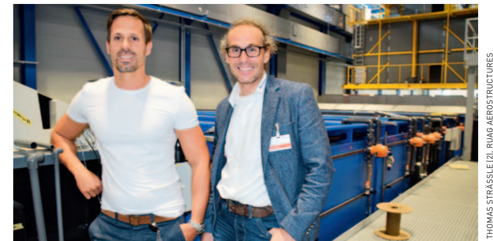
Verantwortlich für den Bau der neuen Oberflächen-Behandlungsanlage von RUAG Aerostructures: Projektleiter Roman Bürgler (links) und Markus Gisler, CEO des Herstellers Galvabau
